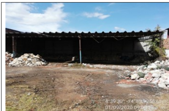
Fotografía 6. Espacio destinado para el acopio temporal de escombros
